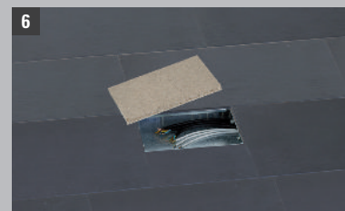
6 Снять защитную заглушку
