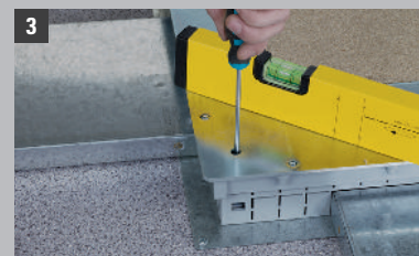
3 Отрегулировать с помощью винтов
