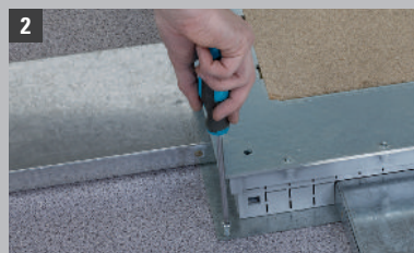
2 Вставить кабель-каналы и привинтить к полу
